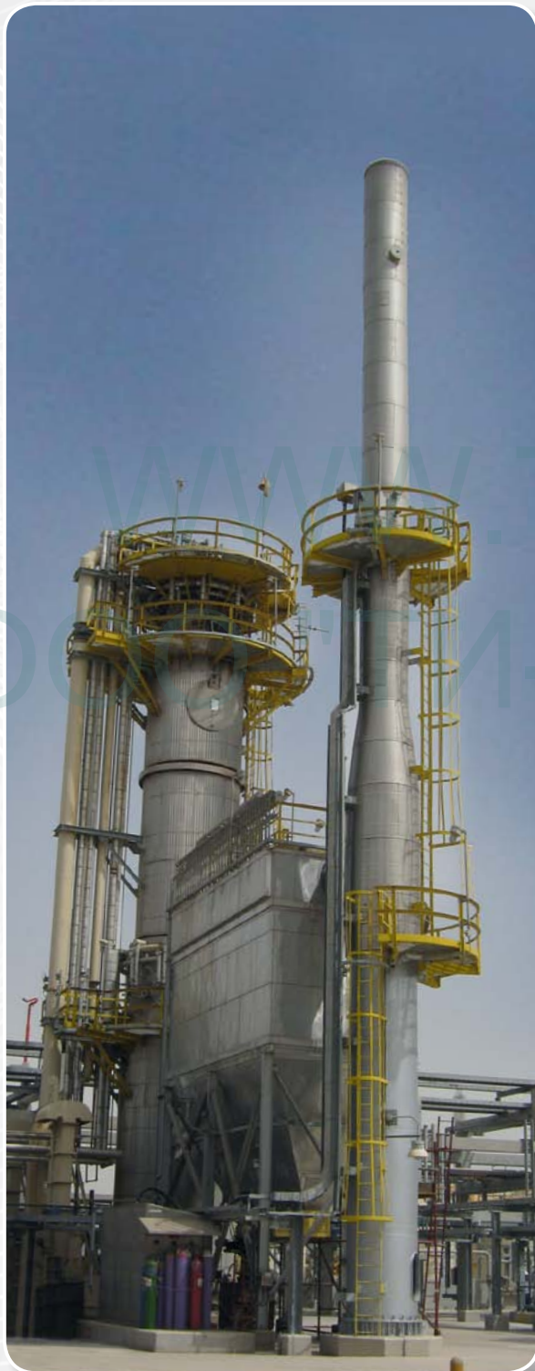
Термический Окислитель Солей ZEESCO с направлением пламени вертикально вниз.
